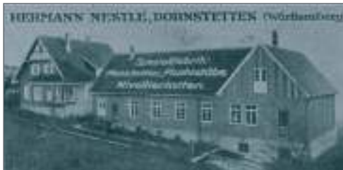
Edificios corporativos en el Riedsteige
